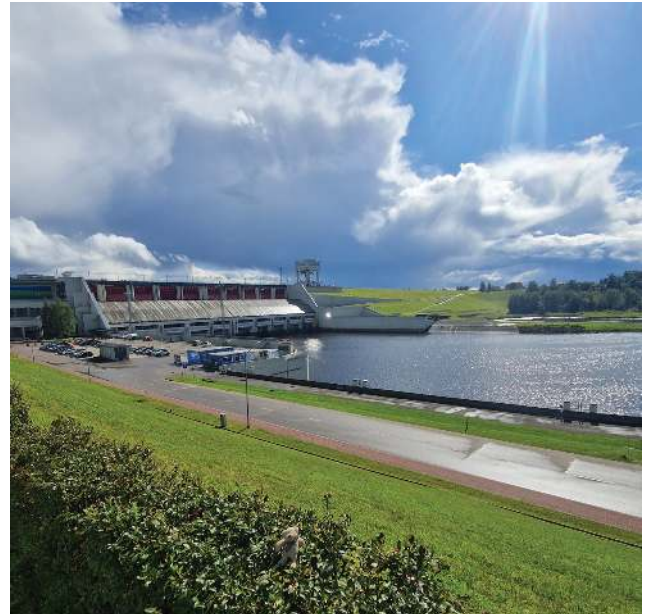
Padon alitse kulkeva tunneli Latviassa
