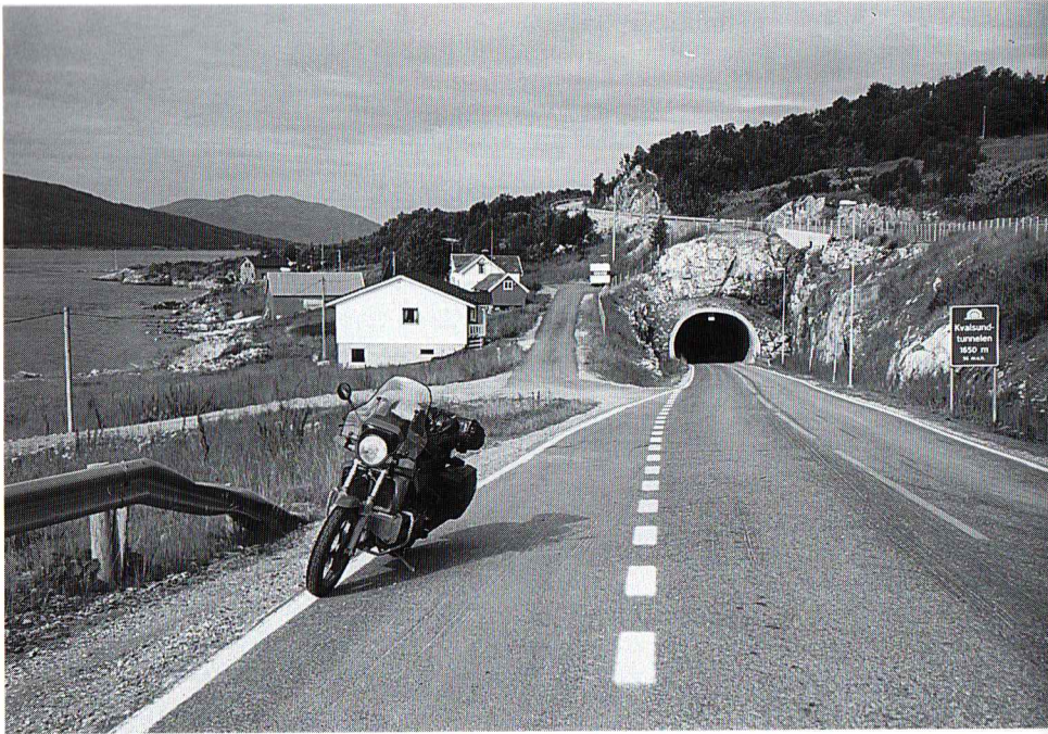
Kvalsund-tunneli, joka alittaa vasemmalla näkyvän salmen.
